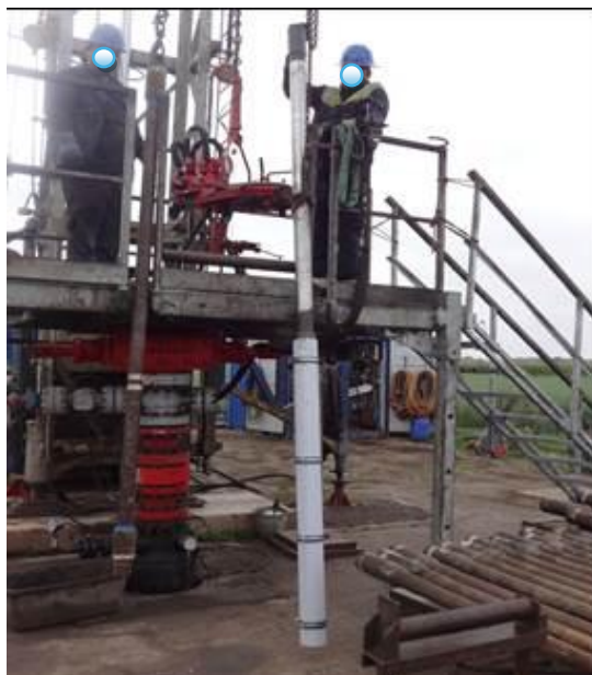
Abb. 18: Einbau des Bentoniträgers in das Bohrloch
